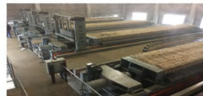
四川泸州某污水处理厂（日处理规模150000T/D）
