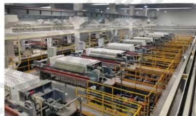
2万吨多晶硅EPC项目
