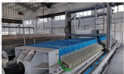
光大水务5万吨市政污水EPC项目
