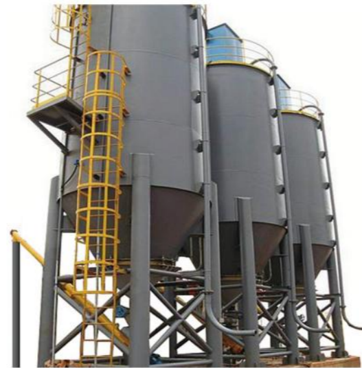
石灰投加系统 Lime dosing systems
